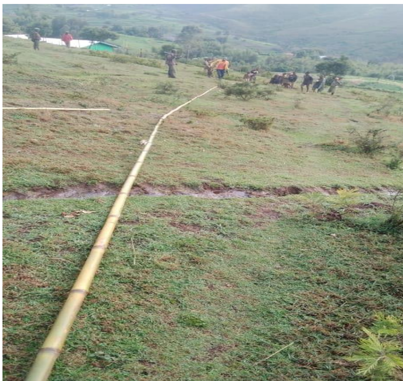
Photo 2 : Pause d'un tuyau pour irrigation en bambou à Mukike
